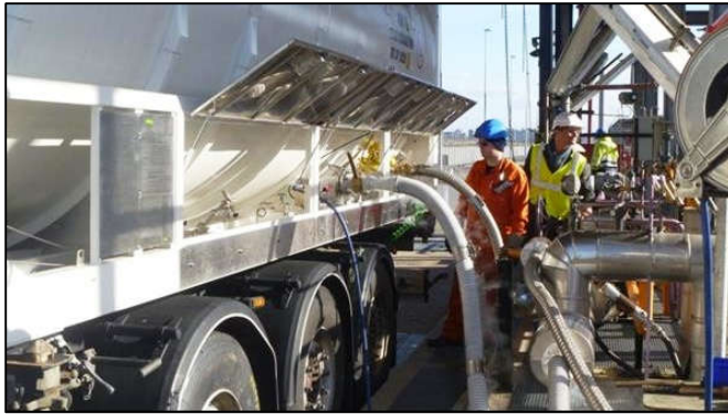
شکل ۴: قرار گرفتن تجهیزات بارگیری و تخلیه تانکرهای قابل حمل در محفظه ای محفوظ
